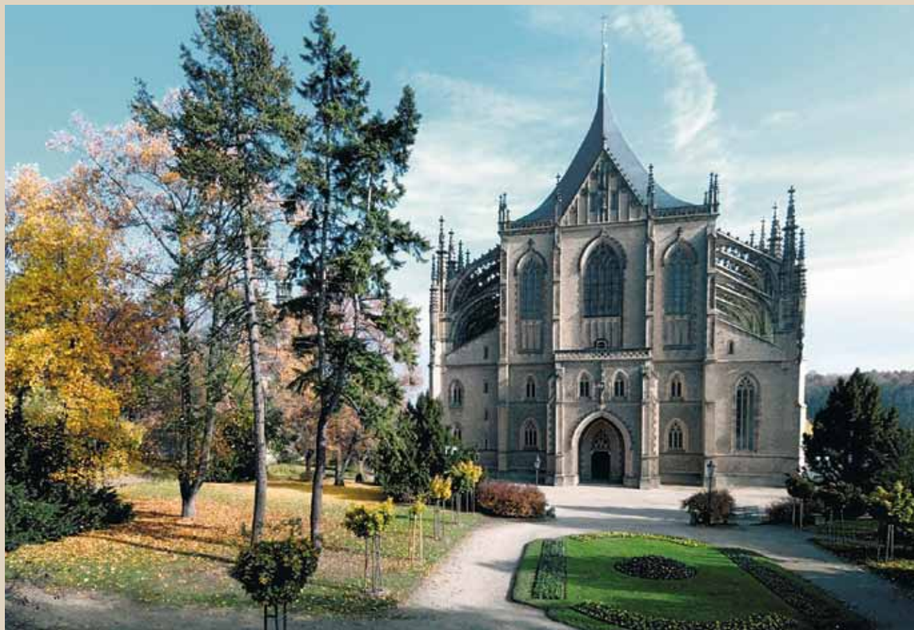
Celkový pohled na zrekonstruovaný kamenný plášť chrámu
