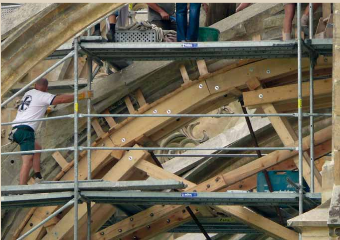
Technické zajištění opěrného oblouku
