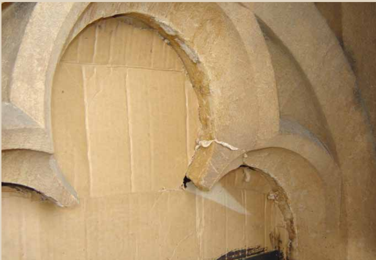
Výměna okenních vitráží
