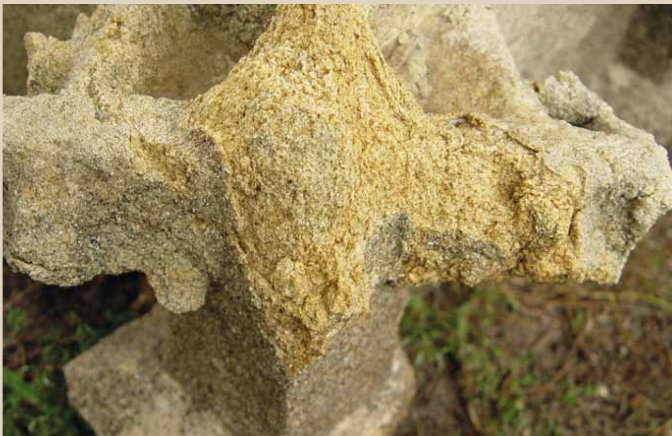
Detail degradace kamenné kytky
