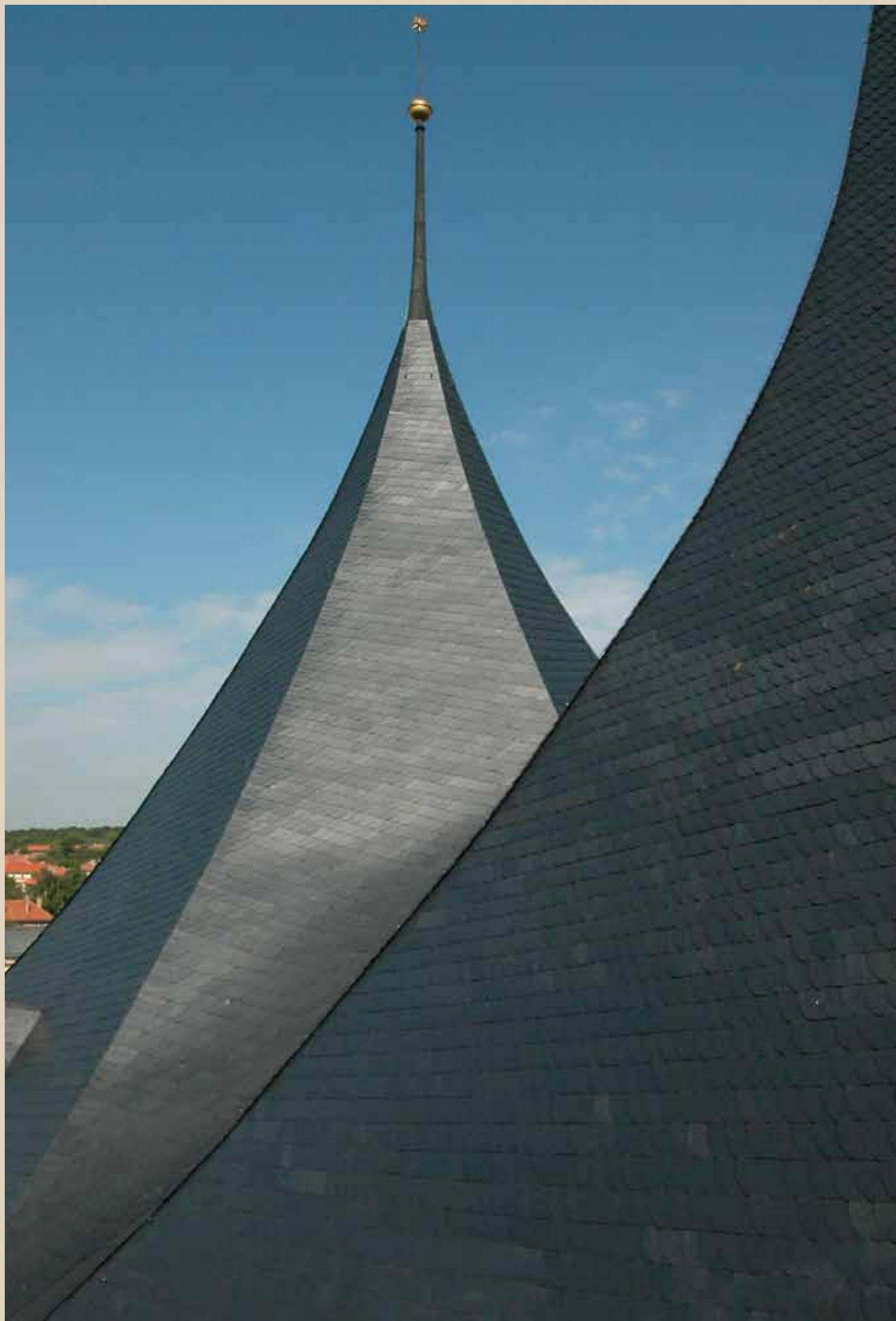
Střecha chrámu – stav po rekonstrukci
