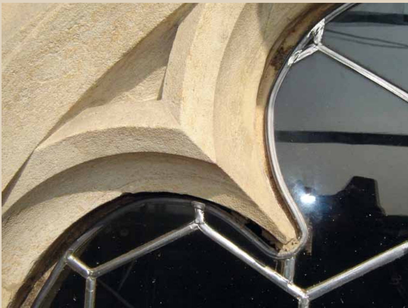
Detail okenní vitráže – po restaurování
