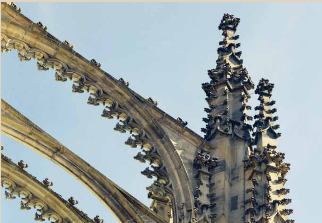
Opěrný systém chrámu – opěrné pilíře a oblouky
