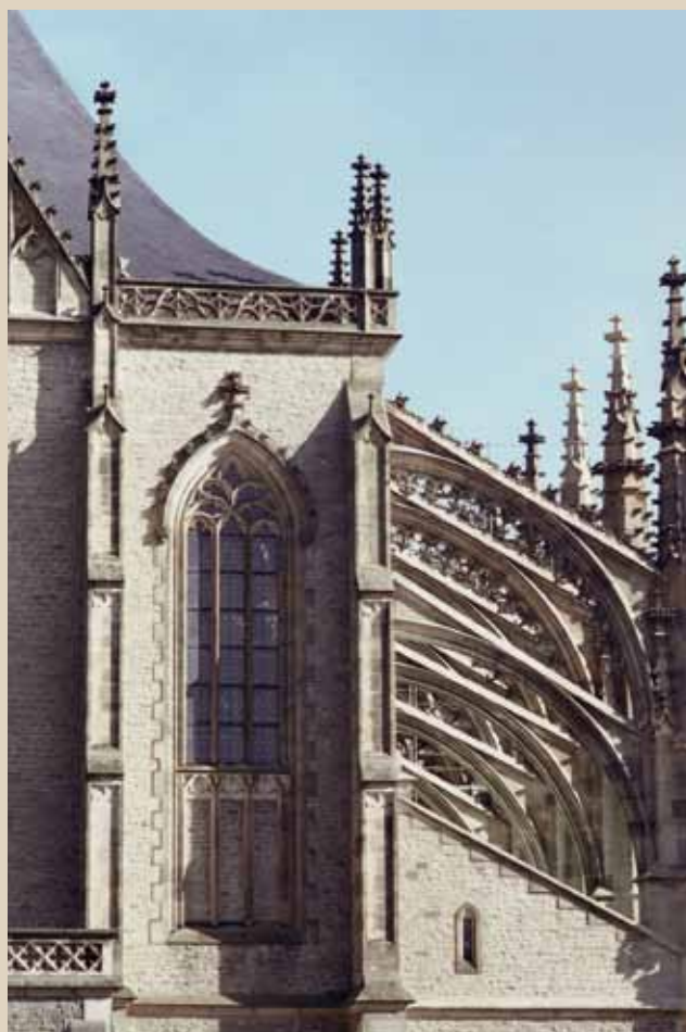
Opěrný systém chrámu – stav po restaurování
