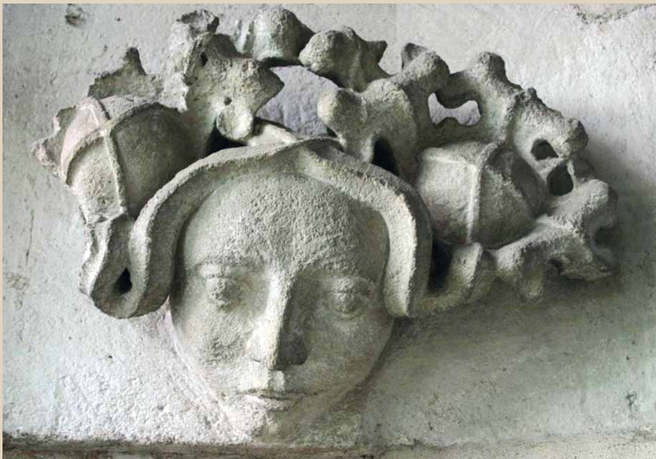
Kamenné prvky – stav před restaurováním
