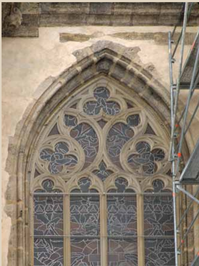
Vitrážová okna – průběh prací z exteriéru
