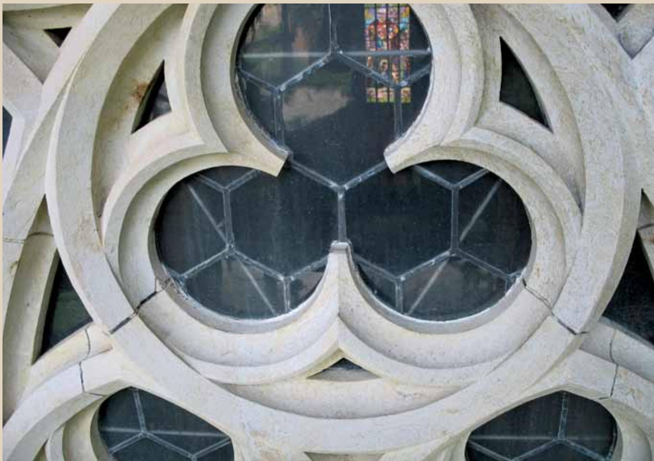
Kamenné prvky vitrážových oken – stav po restaurování
