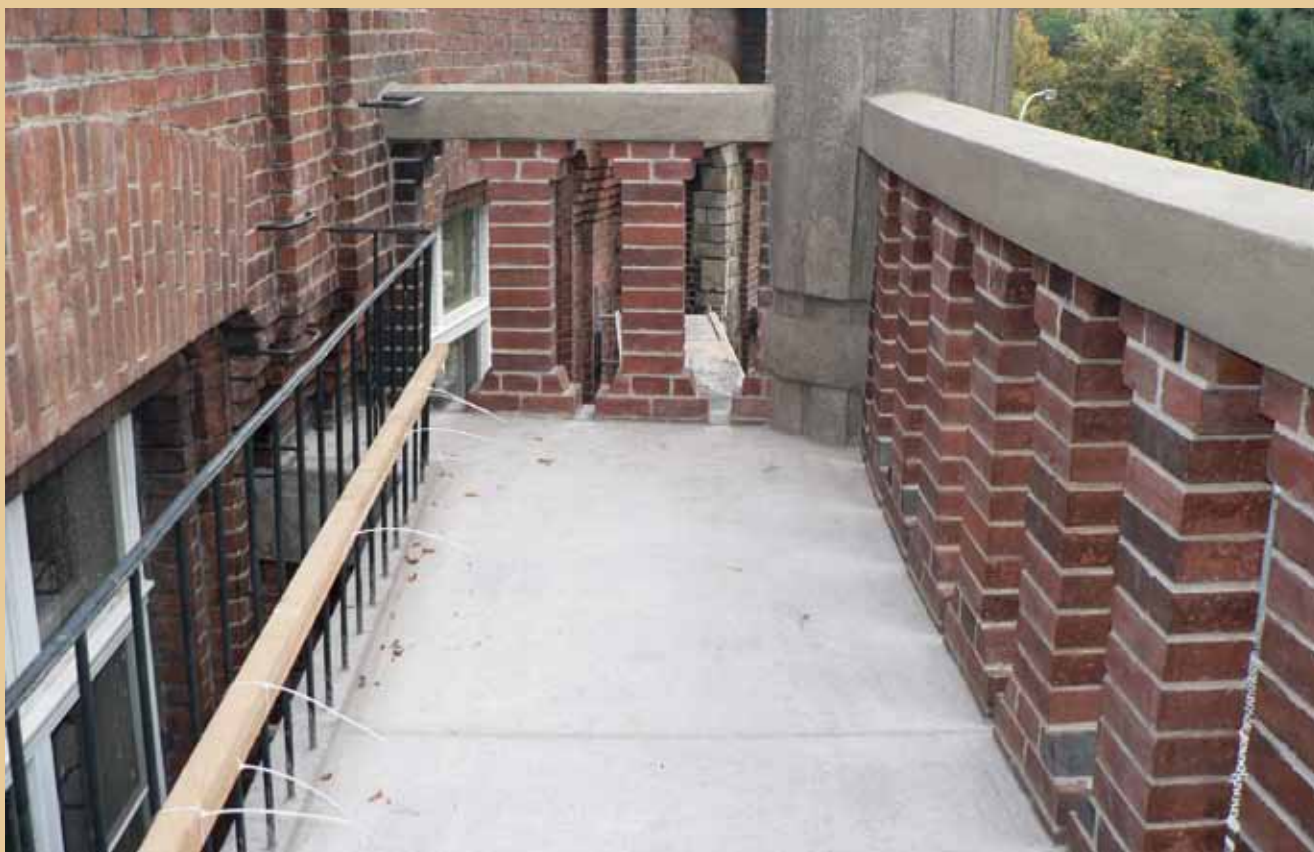
Balkon – stav po rekonstrukci
