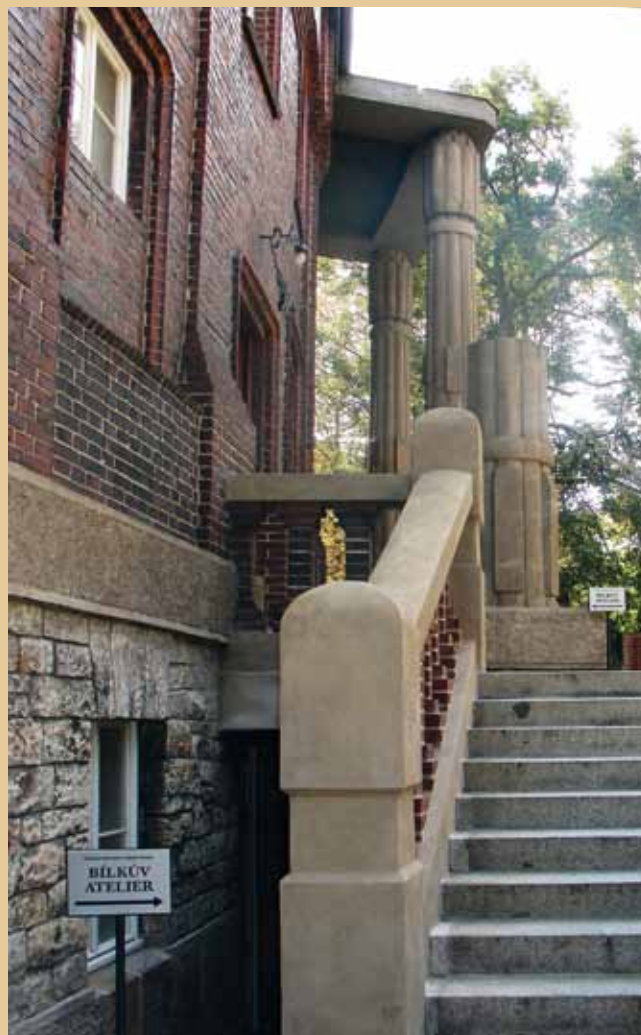
Schodiště po restaurování
