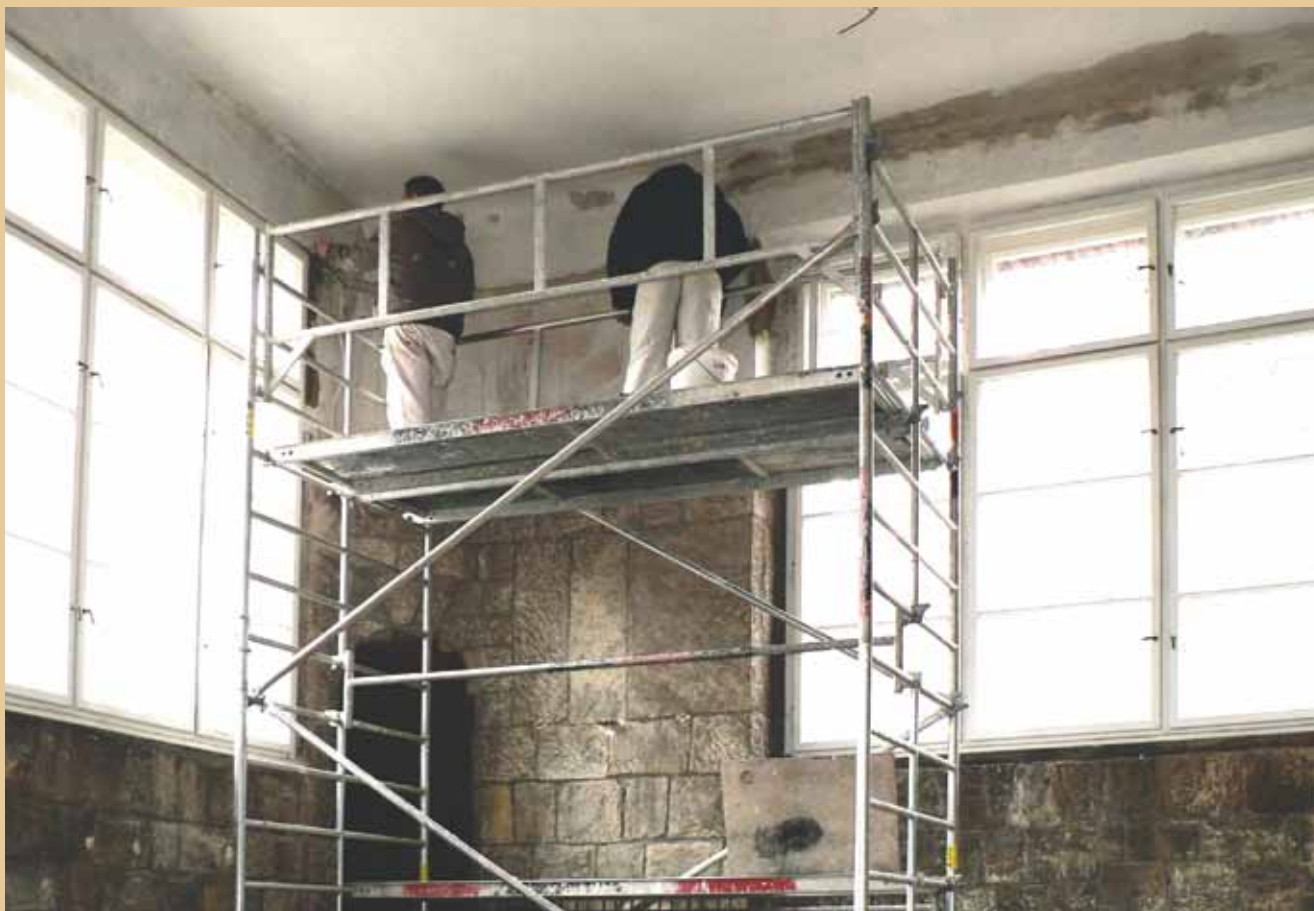
Průběh prací v interiéru
