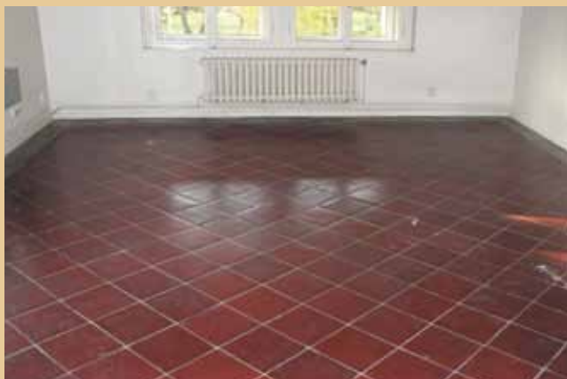
Interiér – stav po rekonstrukci podlahy
