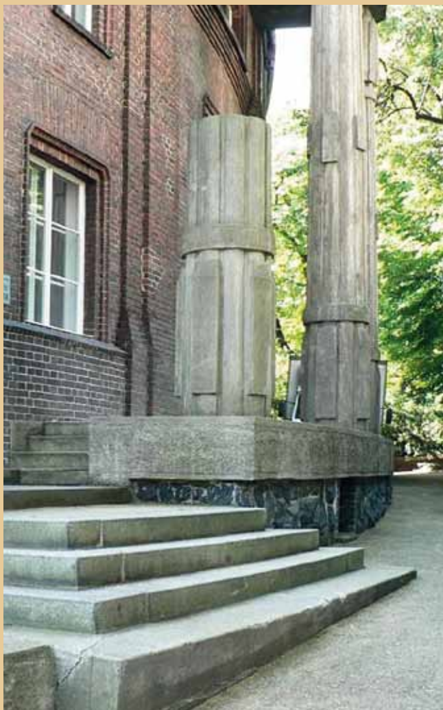
Schodiště před restaurováním
