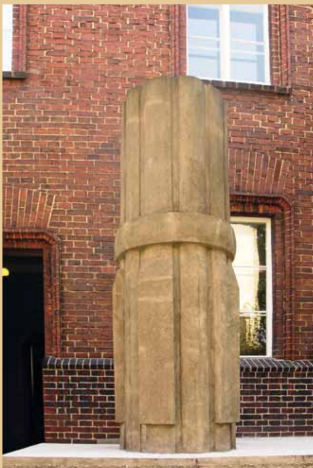
Detail betonového sloupu
