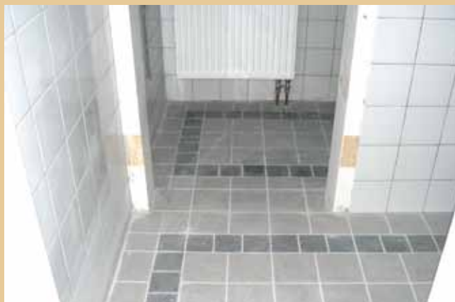
Nově vybudovaná sociální zařízení
