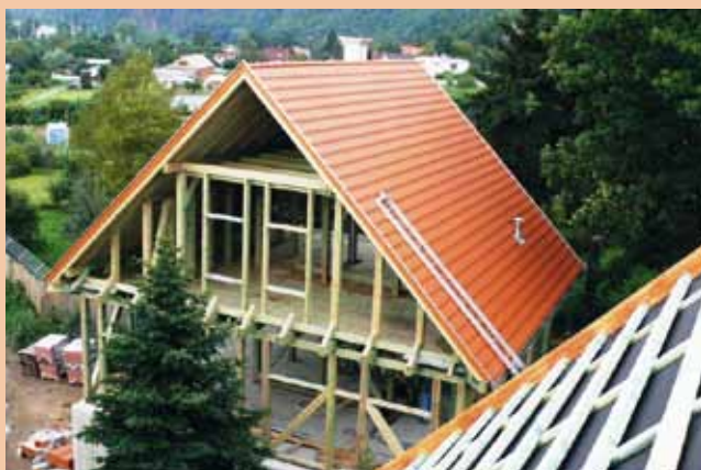
Pokládání nové střechy
