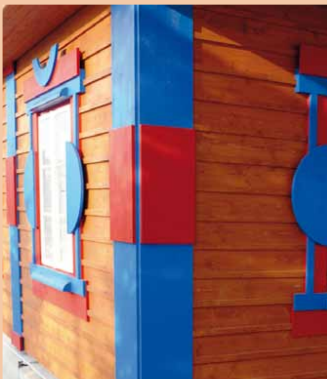
Zdobné prvky exteriéru – stav po dokončení prací
