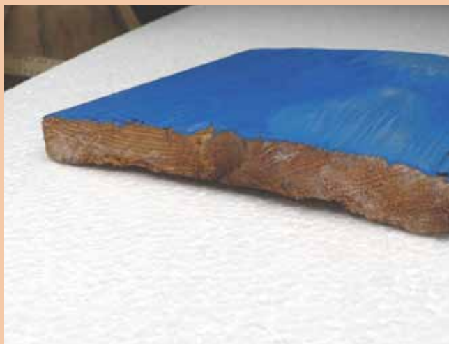
Detail nového nátěru dle původní odstínu
