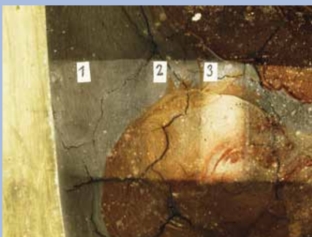
Zkoušky čištění malby
