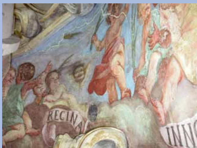
Malba nad oltářem po očištění a vytmelení
