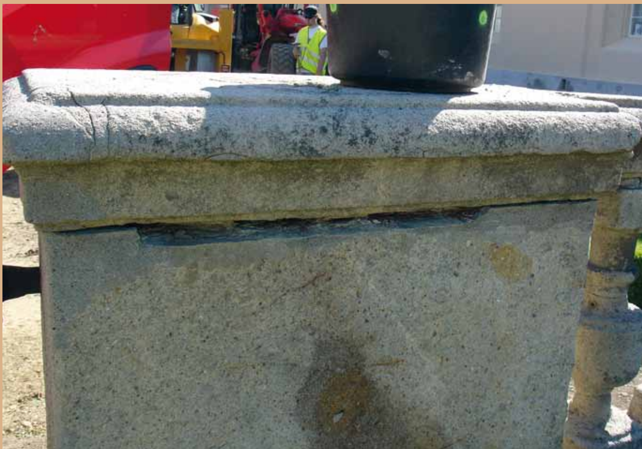
Detail historického zábradlí na nádvoří Květné zahrady – průběh prací
