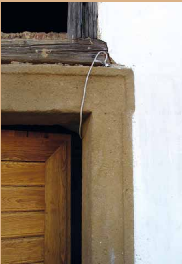
Detail kamenného ostění
