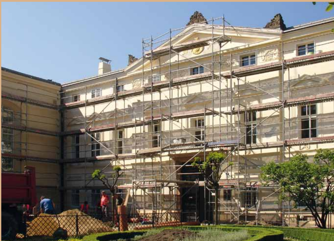
Historické kamenné detaily na vstupní budově – průběh prací
