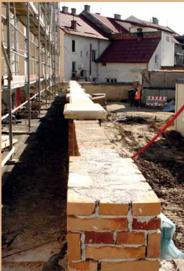
Pokládka kamenného zábradlí na terase skleníku
