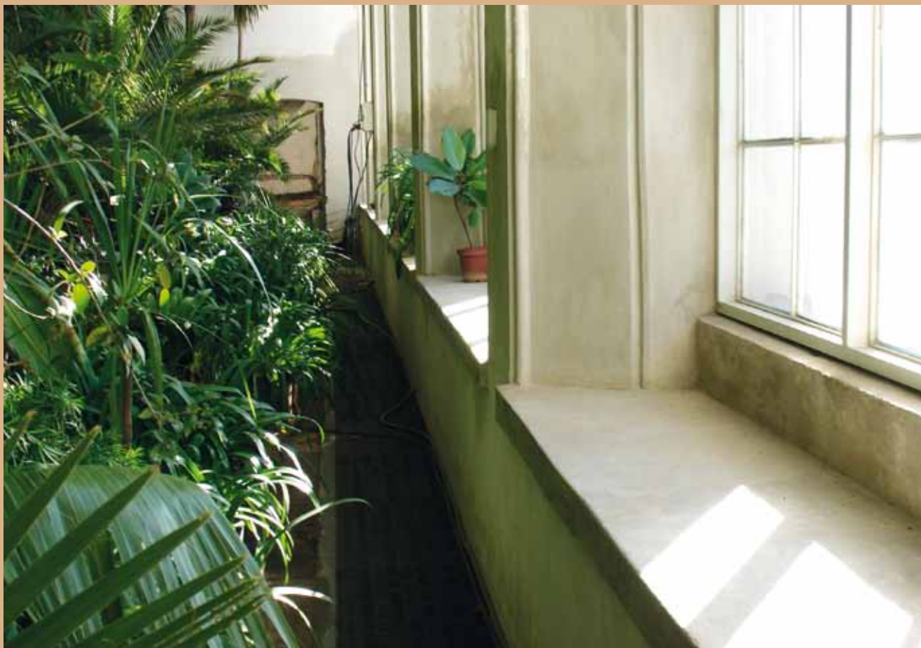
Restaurování kamenných parapetů ve skleníku
