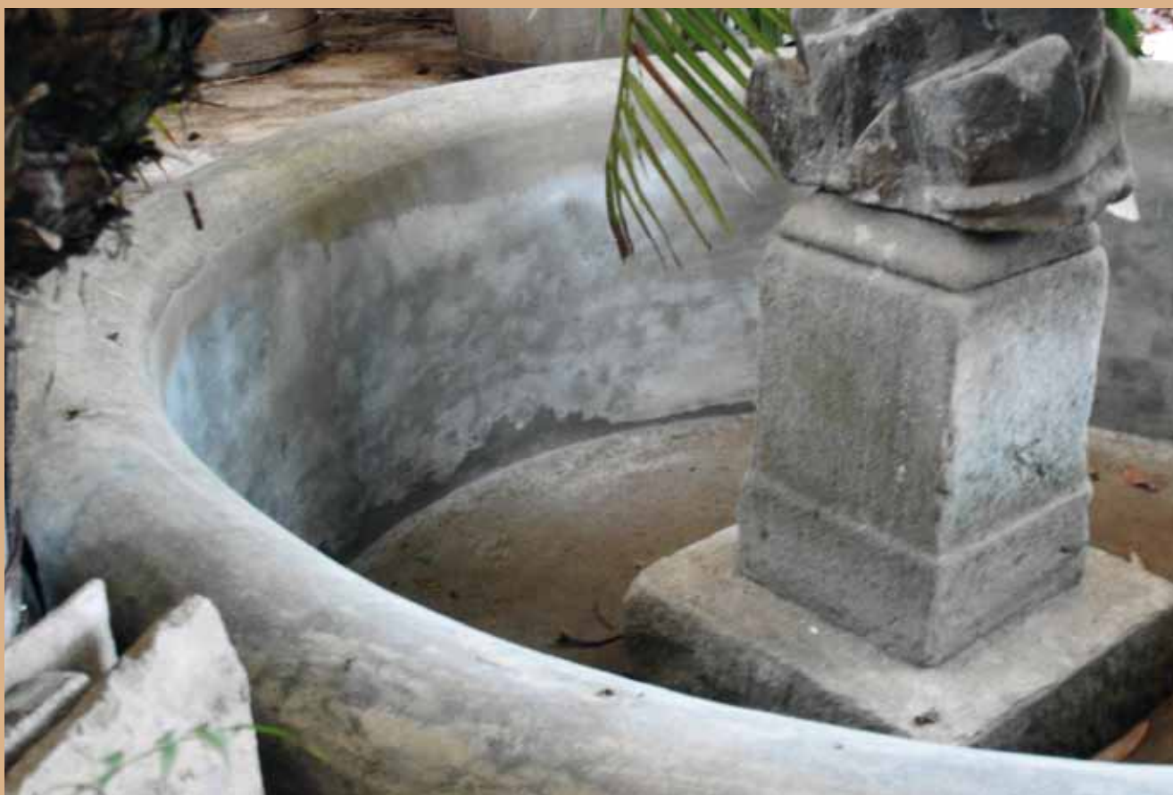
Detail kamenného bazénku
