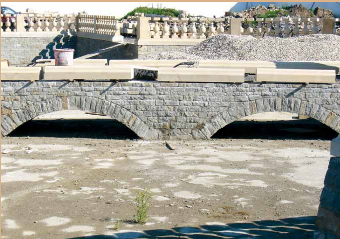
Pokládka kamenné dlažby na mostě vedoucím k Ptáčnici
