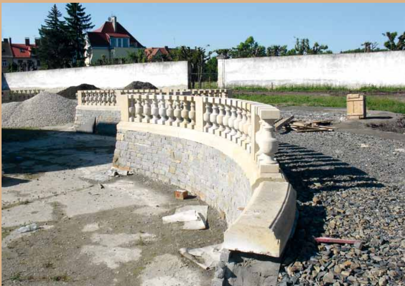
Instalace kamenné balustrády kolem Ptáčníce
