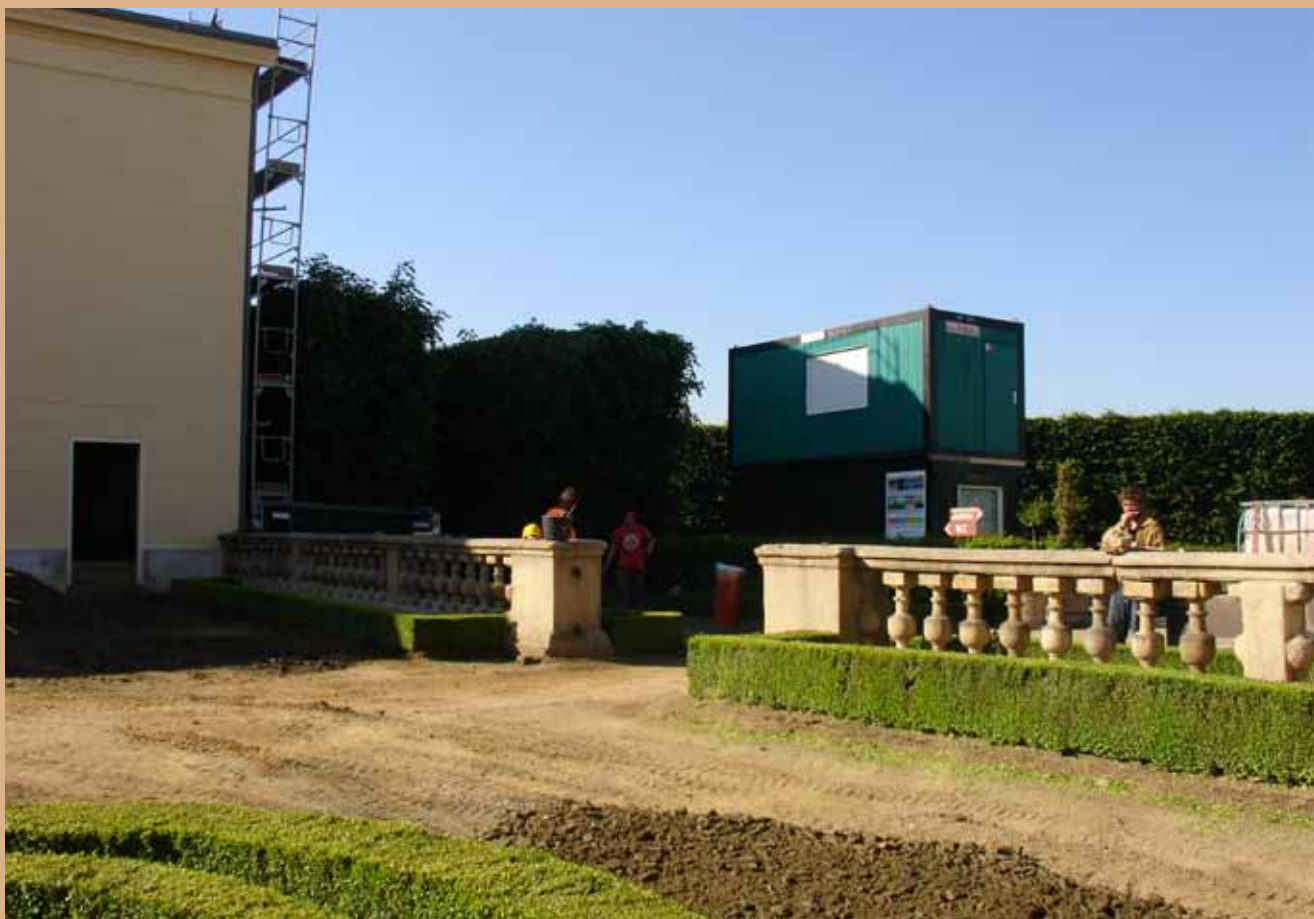
Celkový pohled na barokní balustrádu – průběh prací
