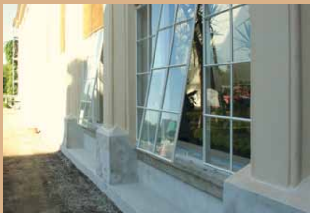
Stav oken a parapetů – po restaurování
