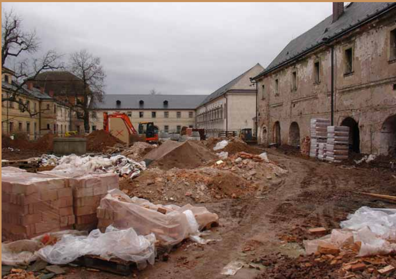
Nádvoří – stav na počátku rekonstrukce
