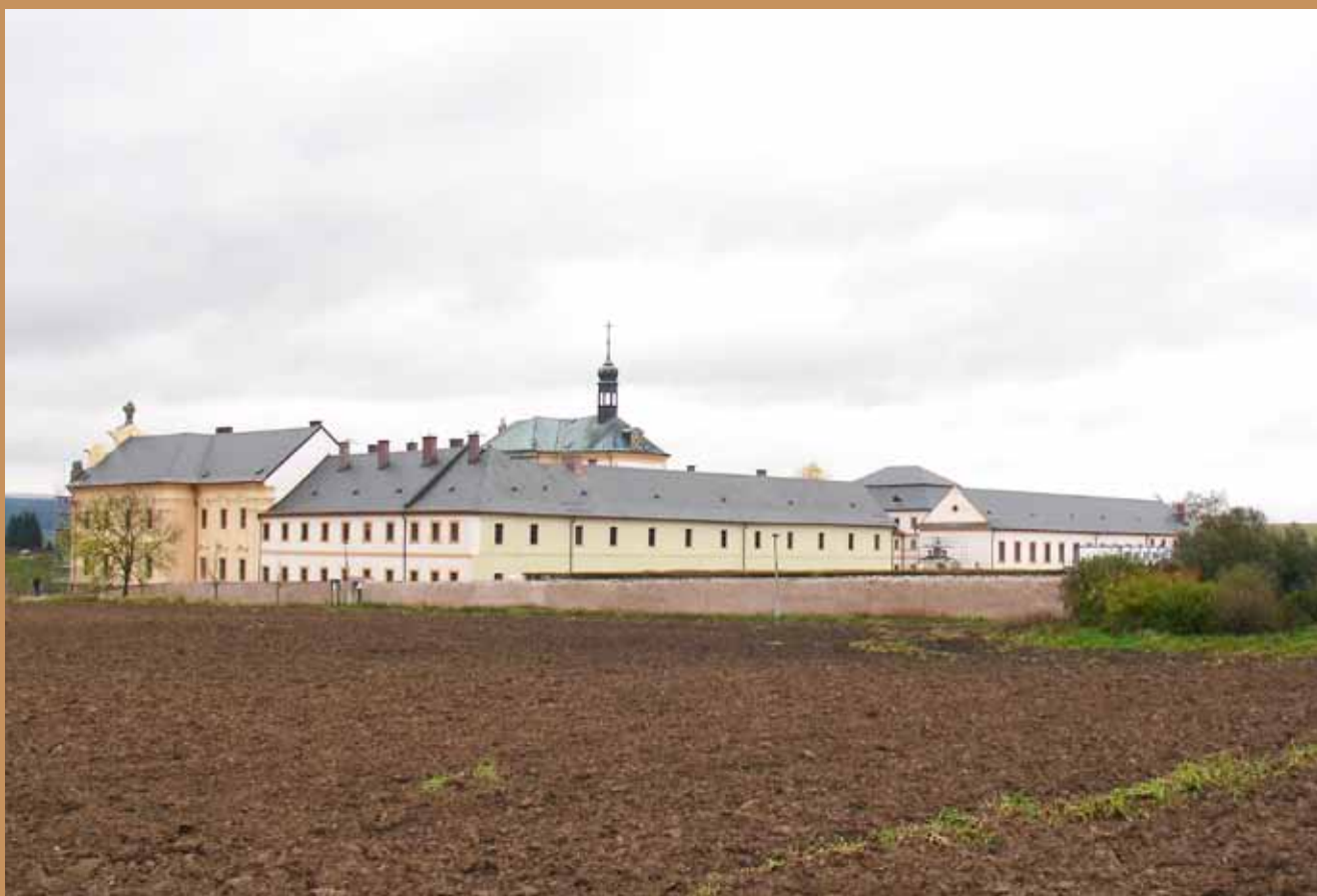
Celkový pohled na hospital Kuks po rekonstrukci
