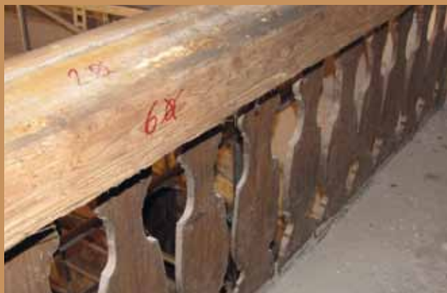
Polychromované zábradlí v kapli – průběh prací
