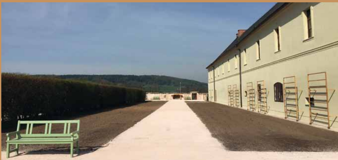
Stav po rekonstrukci
