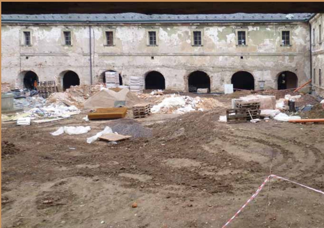
Stav fasády a nádvoří před rekonstrukcí
