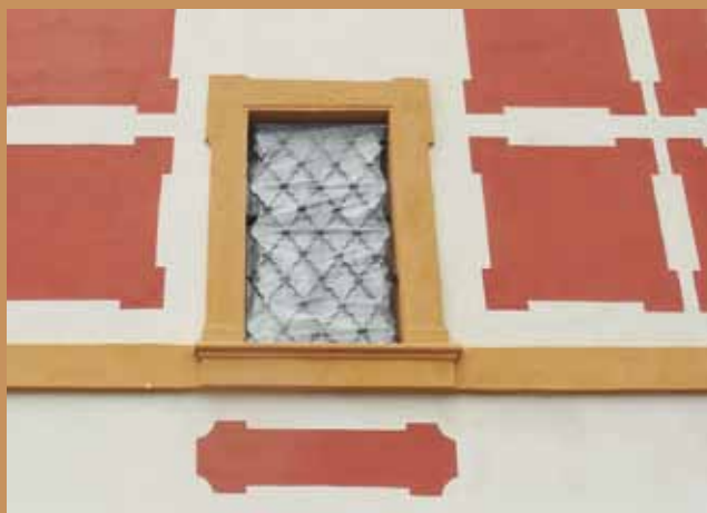
Nově zrestaurované kovové mříže – instalace
