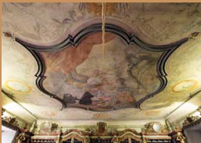
Stav malby po restaurování
