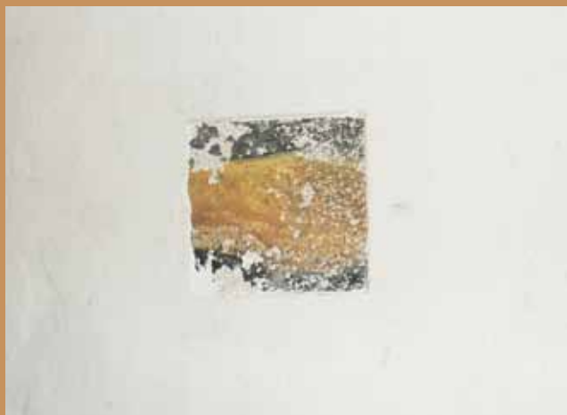
Zjišťovací sonda před započatím odkryvů malby
