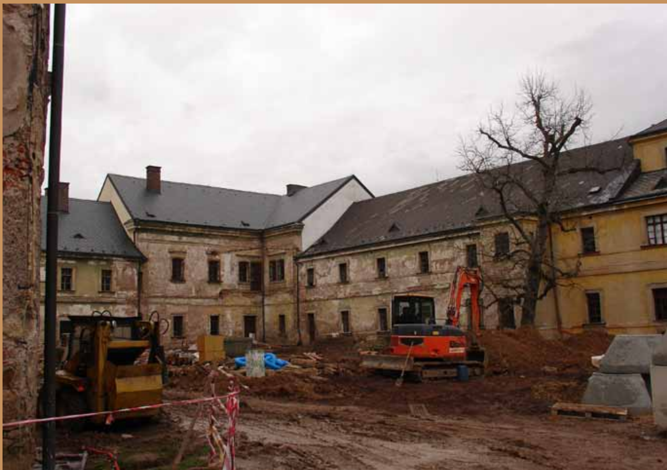
Nádvoří – stav na počátku rekonstrukce
