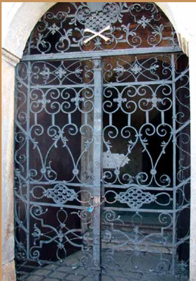
Kovaná vrata – stav po restaurování
