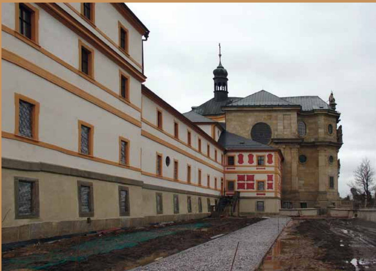
Stav po rekonstrukci
