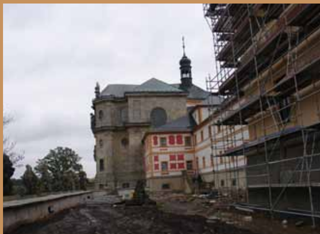
Průběh rekonstrukce fasády
