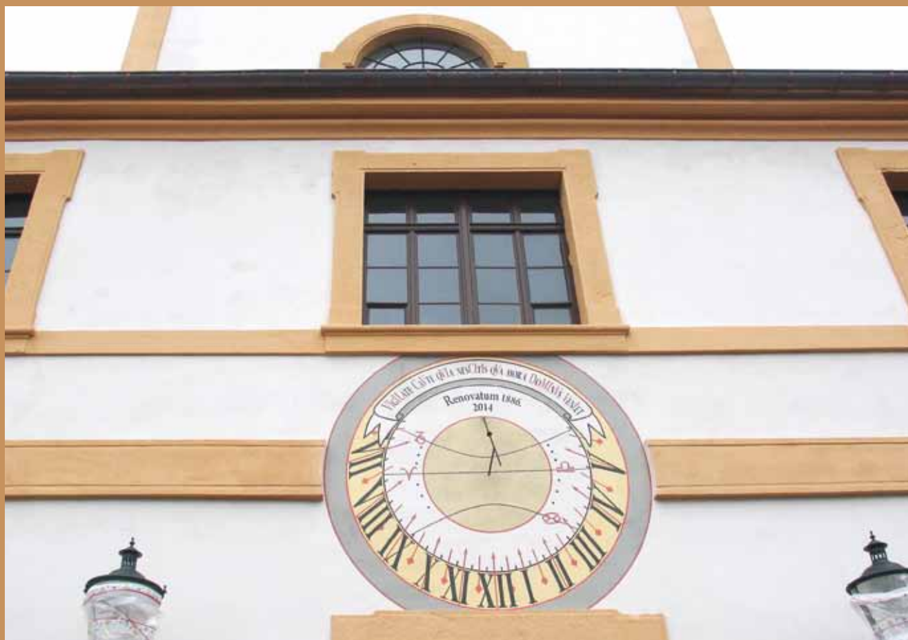
Průčelí budovy – stav po restaurování
