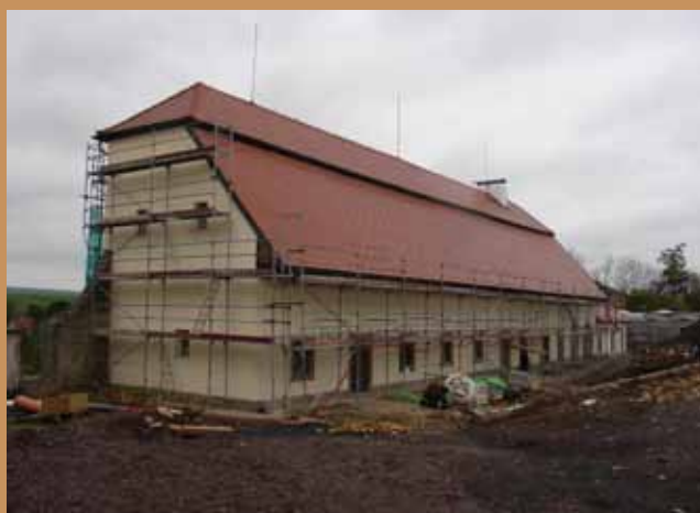
Bývalá restaurace – průběh rekonstrukce
