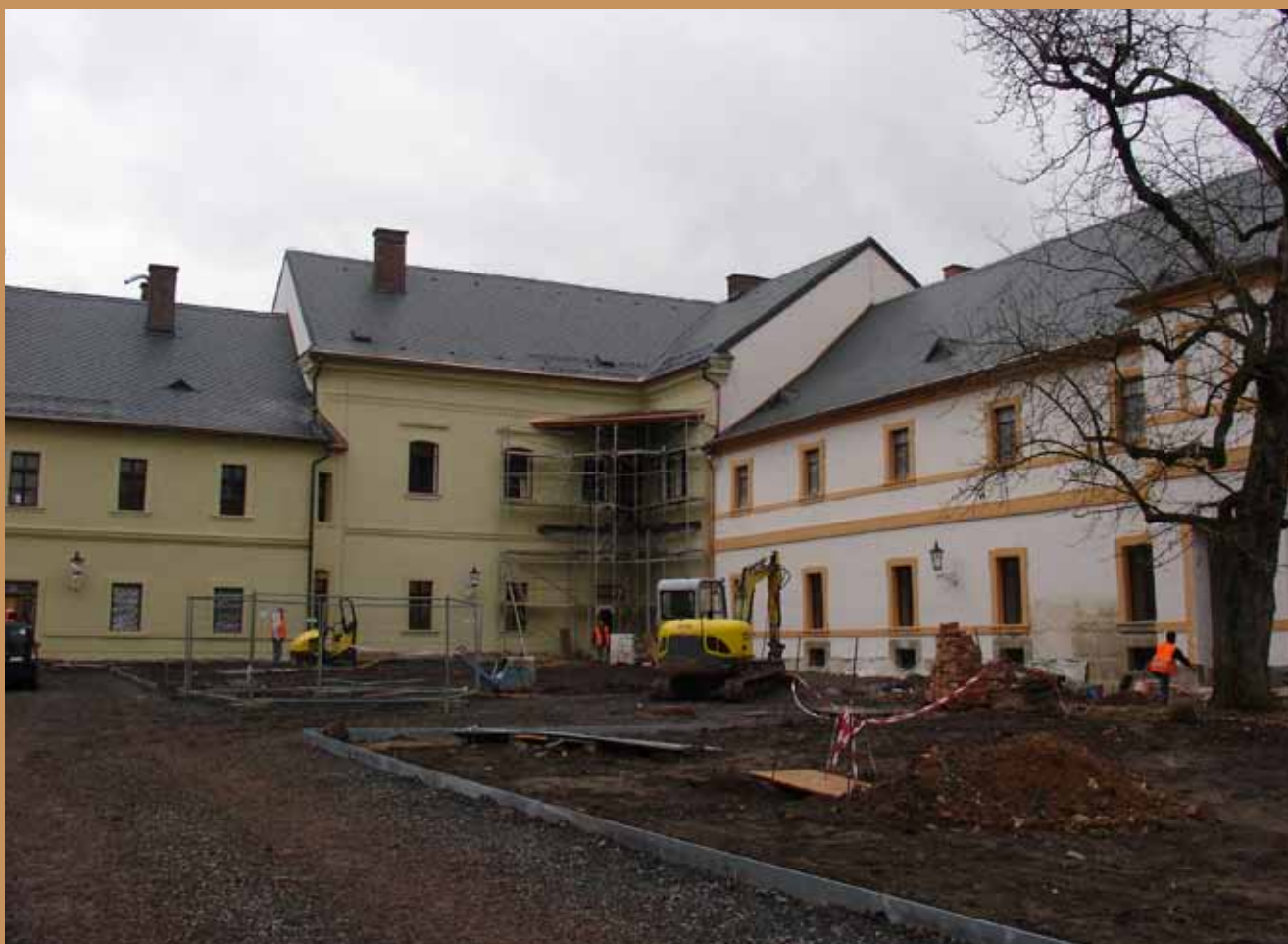
Nádvoří – těsně po dokončení
