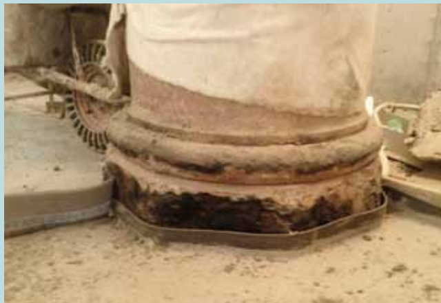
Patek sloupu v bazénové hale – po odkrytí betonové vrstvy
