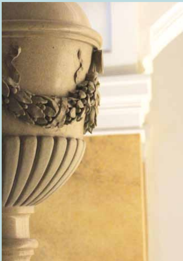
Kamenná váza u hlavního schodiště – stav po restaurování
