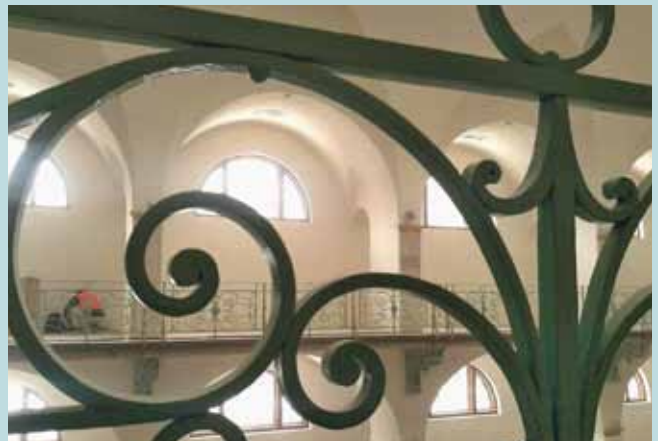
Detail kovového zábradlí
