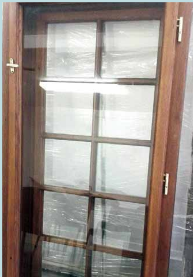
Přesná replika původních oken před osazením
