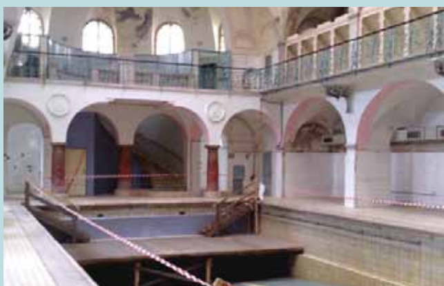
Bývalá bazénová hala před rekonstrukcí
