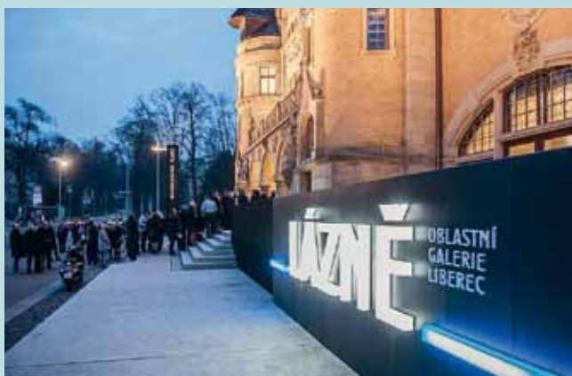
Instalace světelného nápisu
