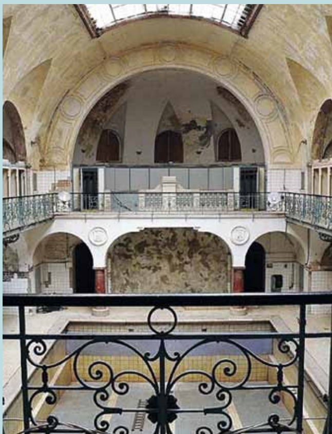
Bazénová hala – stav před restaurováním
