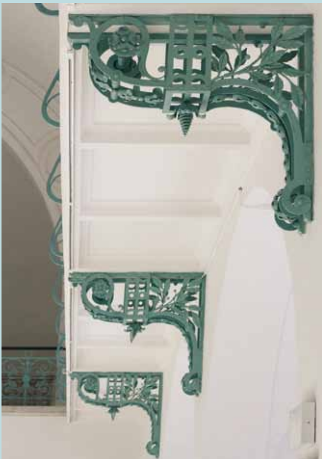
Kovové konzoly – stav po restaurování
