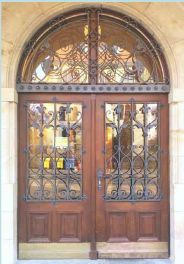
Původní vstupní dveře – stav po restaurování
