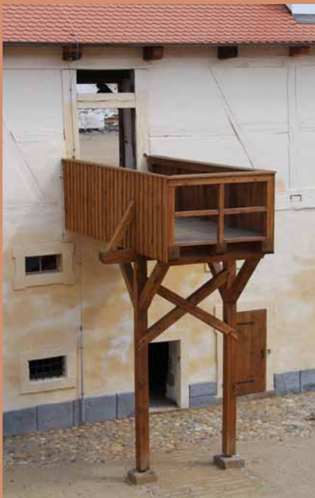
Stav po celkové rekonstrukci
