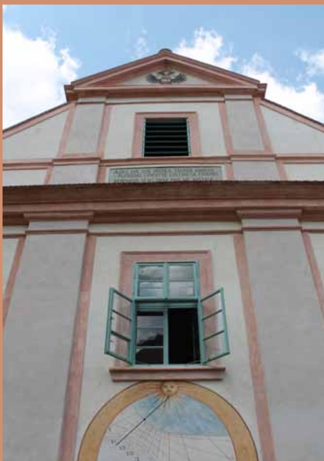
Průčelí budovy s nástěnnou malbou – po restaurování
