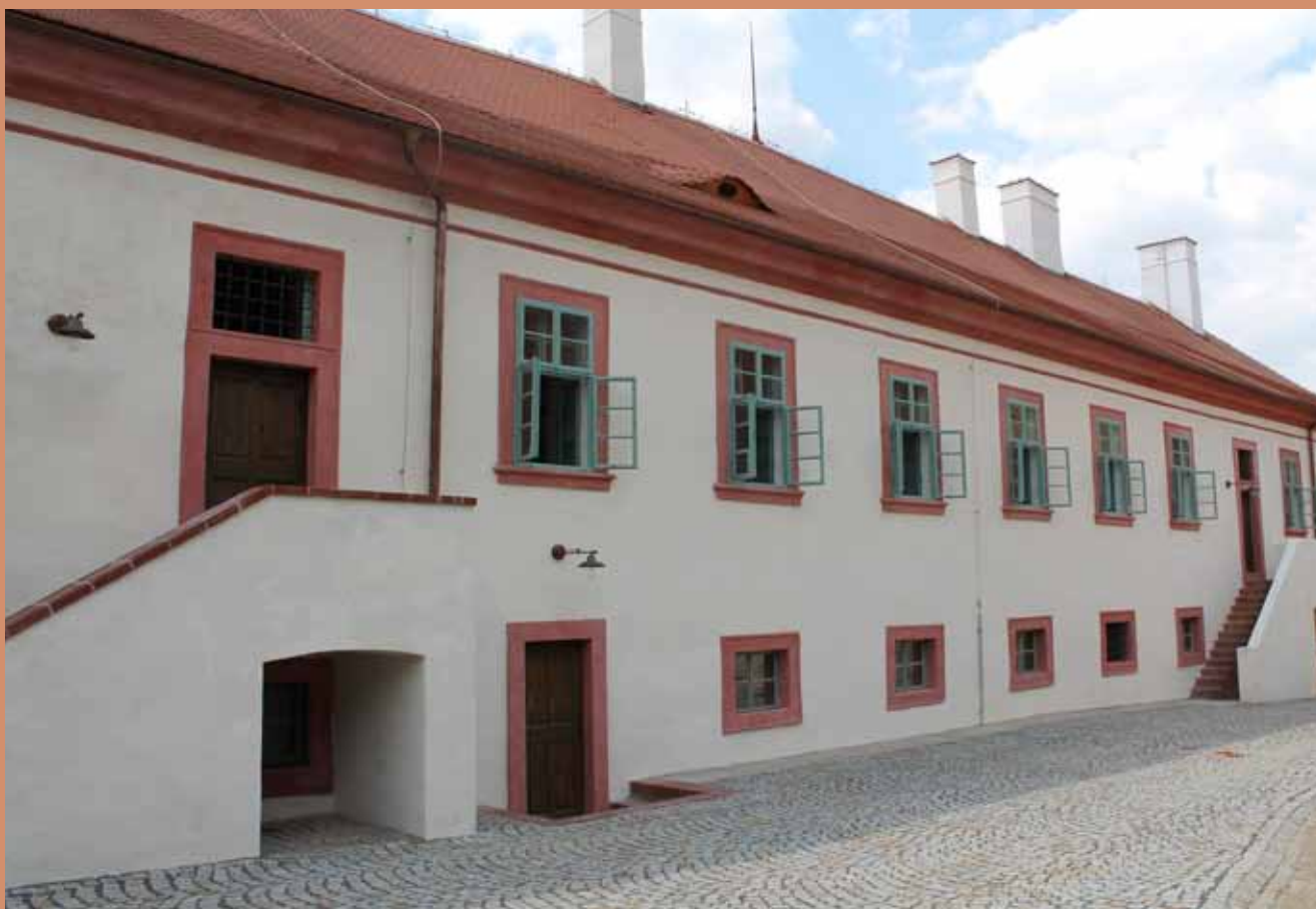
Stav po rekonstrukci
