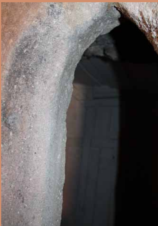
Detail ostění románského okna
