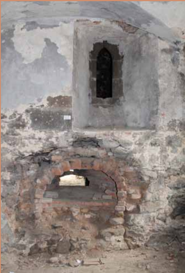
Původní pec a gotické okno
