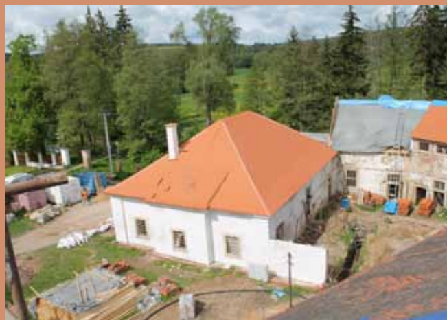
Pokládka střešní krytiny
