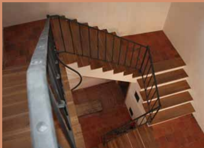
Nově zrekonstruované schodiště
