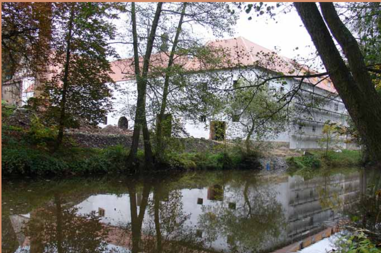
Práce na fasádě objektu
