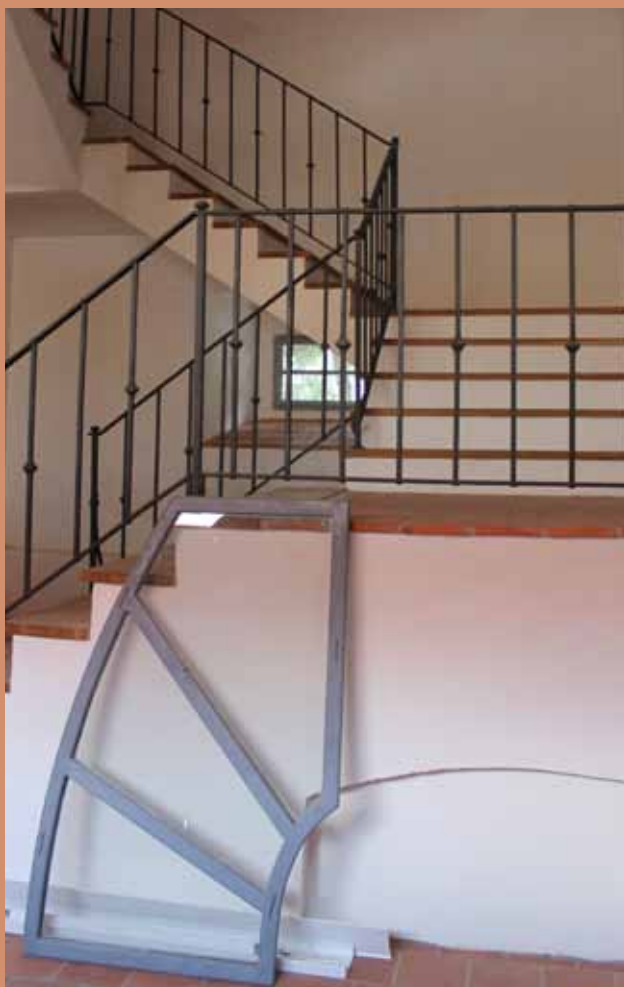
Nově zrekonstruované schodiště
