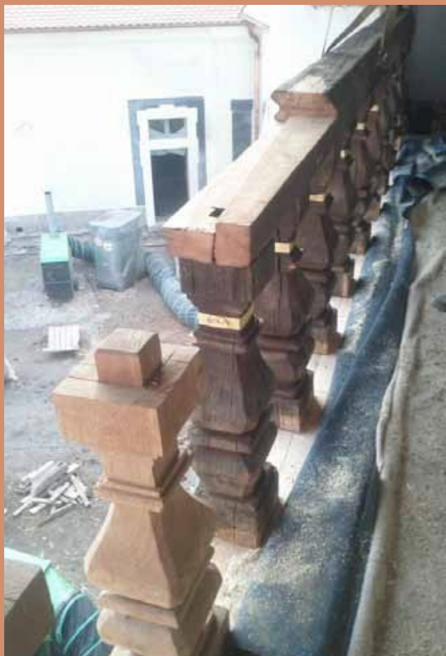
Dřevěná balustráda – průběh restaurování
