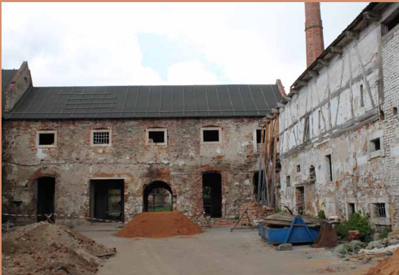
Stav před rekonstrukcí
