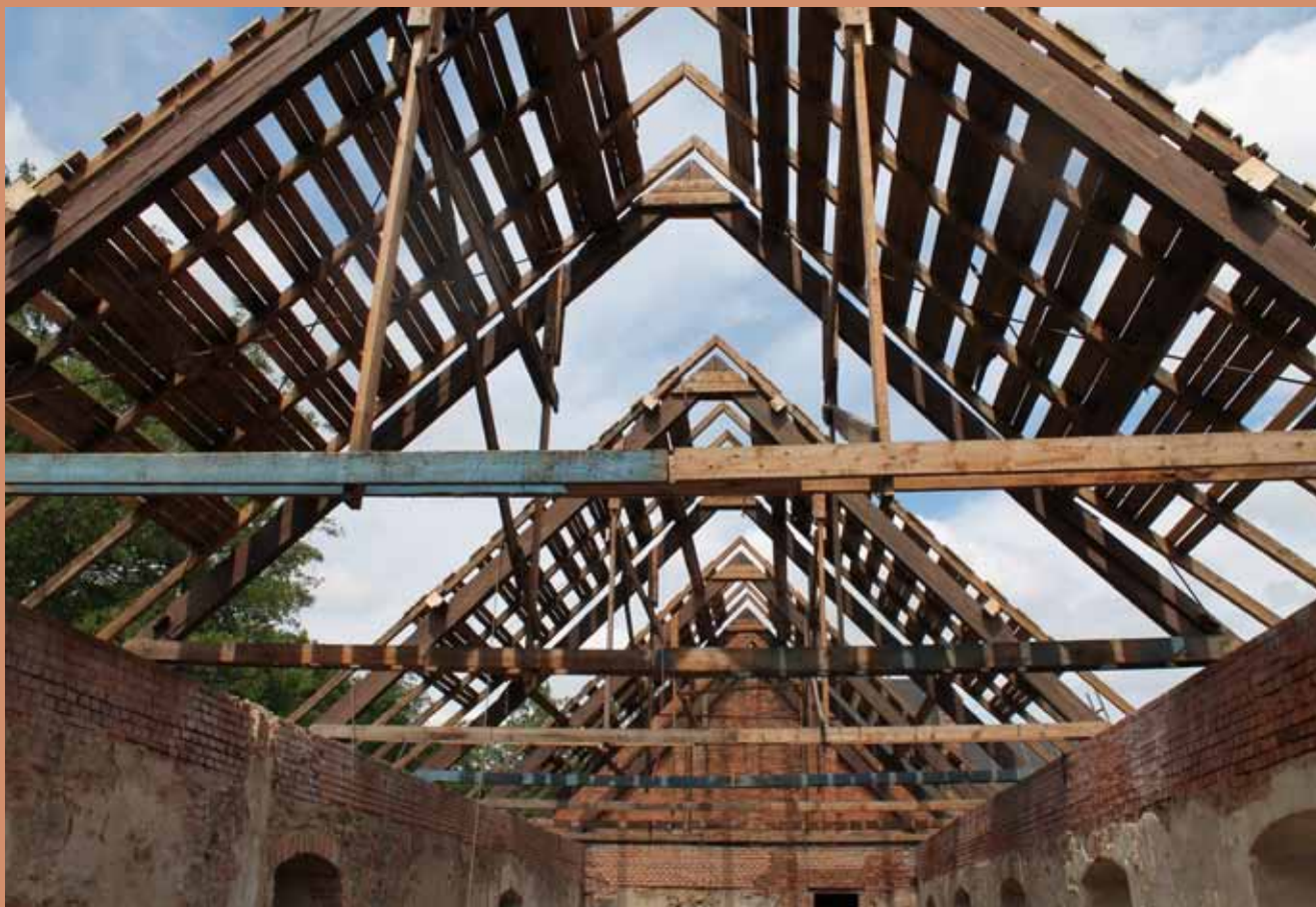
Stav jednoho z krovů před rekonstrukcí
