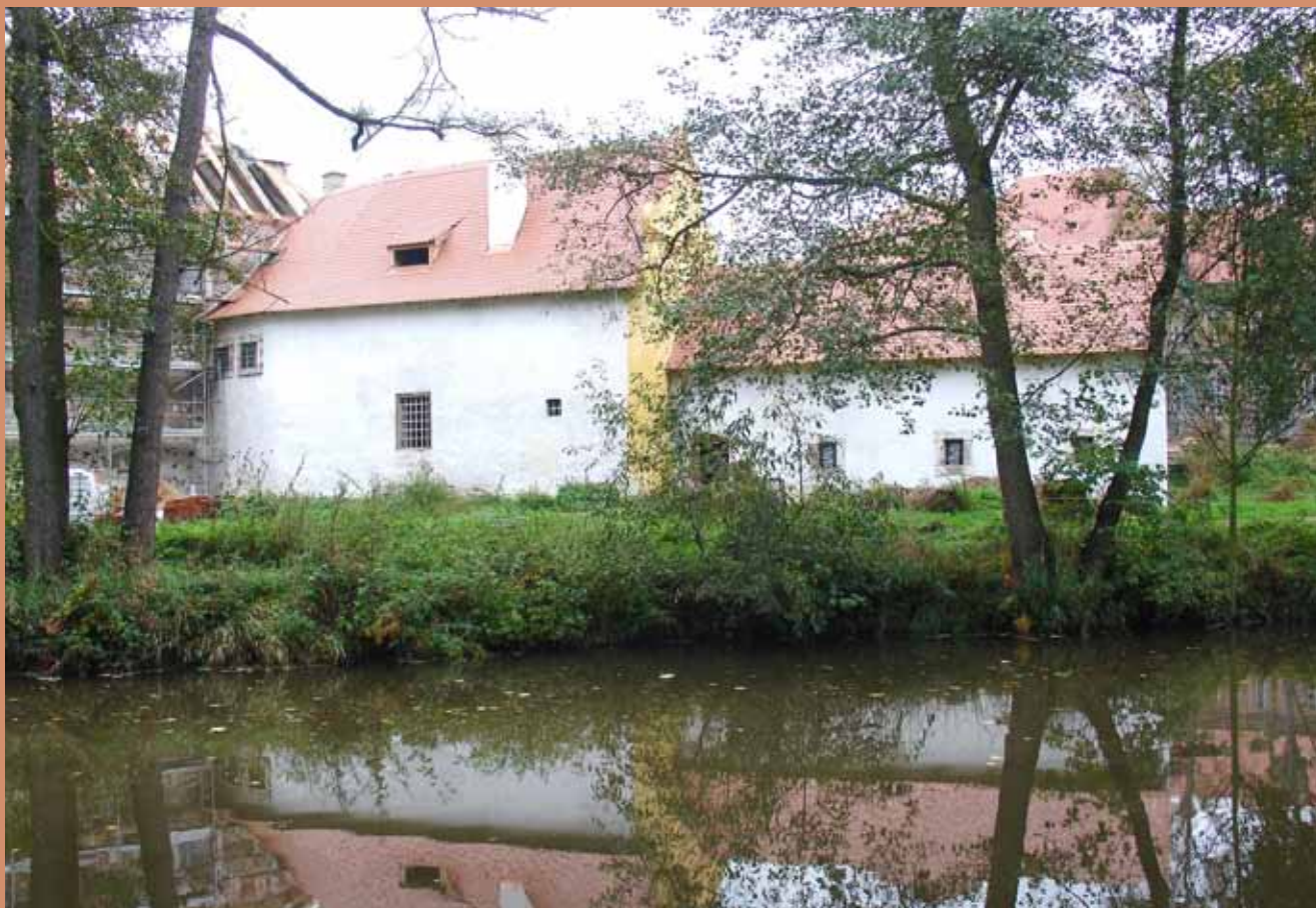
Práce na fasádě hospodářského dvora
