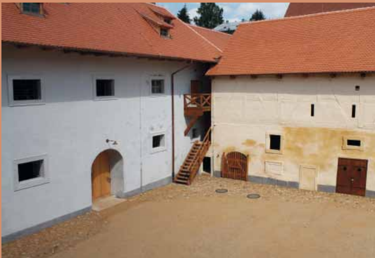
Stav po rekonstrukci
