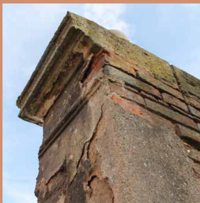
Detail kamenné římsy štítu – před restaurováním
