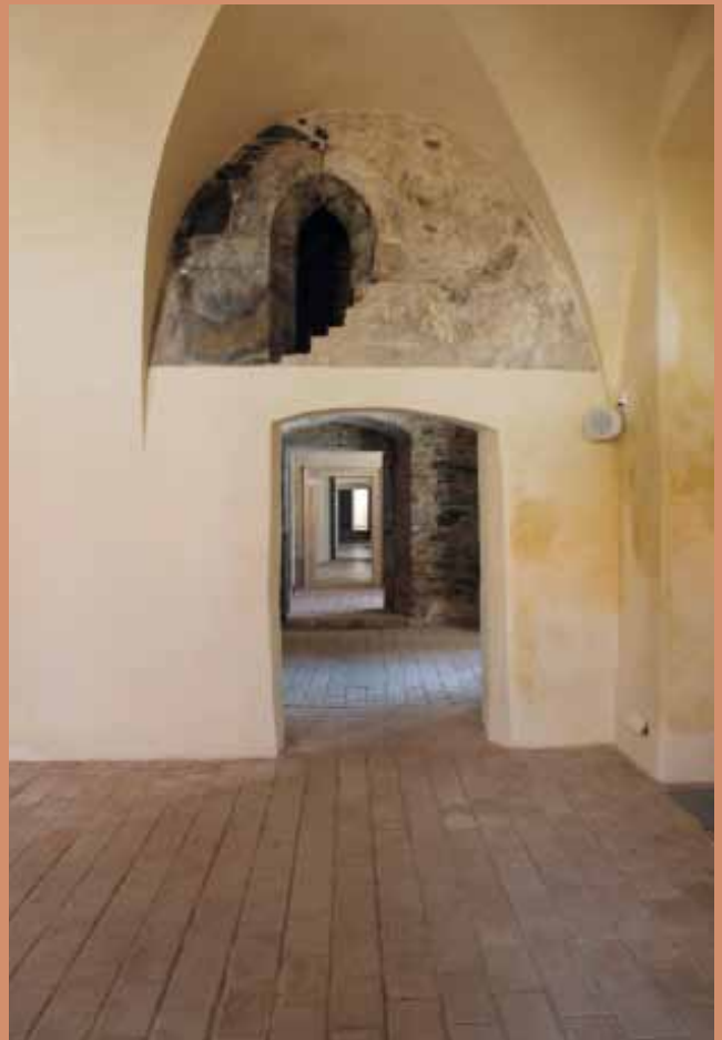
Gotické okno a interiér po restaurování
