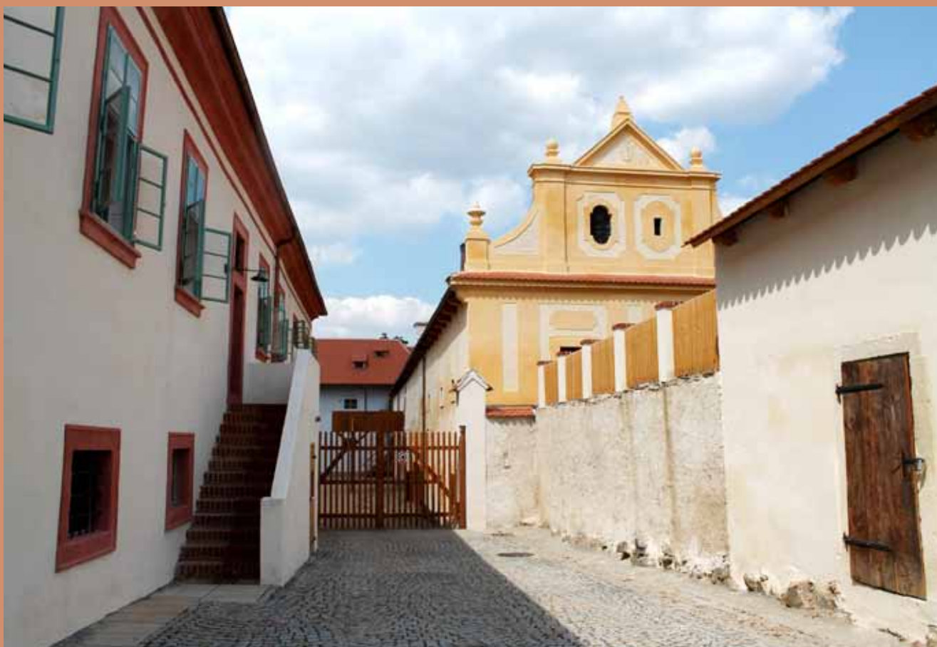
Stav po rekonstrukci
