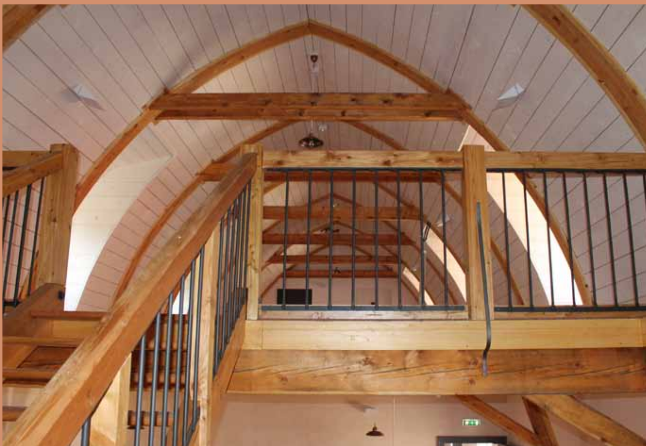
Stav jednoho z krovů po rekonstrukci
