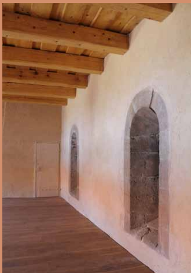
Stav po restaurování
