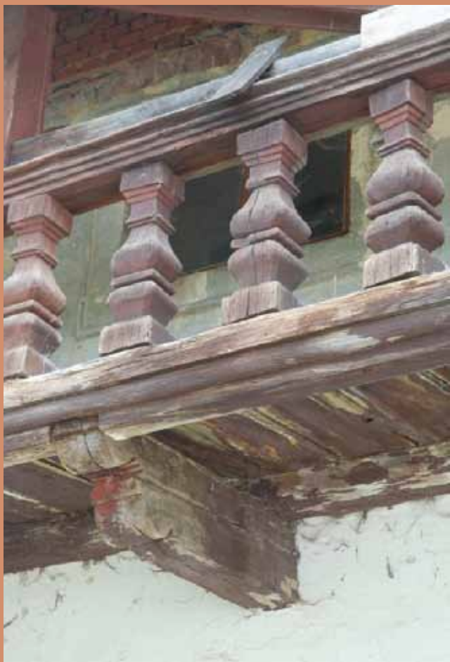
Původní dřevěná balustráda před restaurováním
