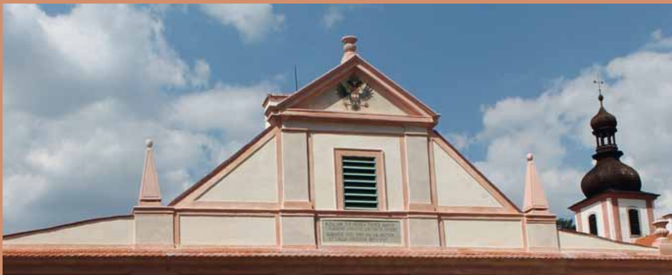
Zdobné kamenné prvky na štítu budovy – po restaurování
