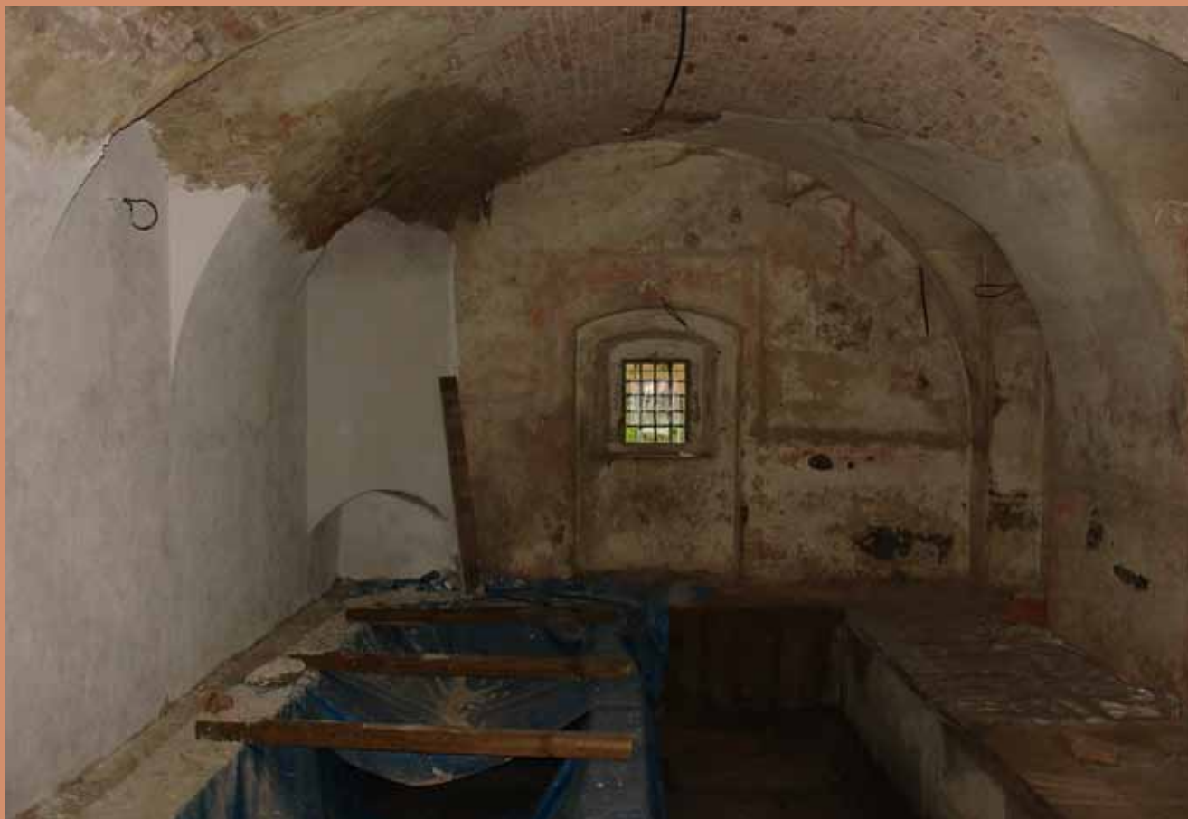
Kamenné kádě na ryby – průběh prací
