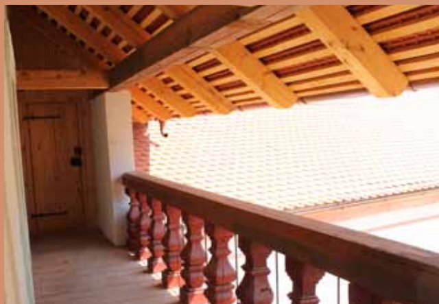
Stav historické balustrády po restaurování
