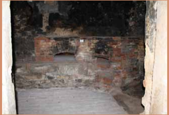
Černá kuchyně – restaurátorský průzkum
