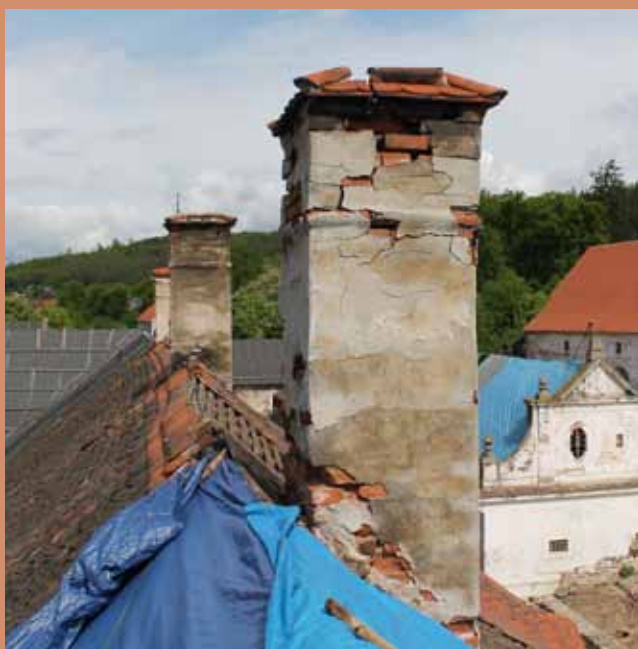
Stav před započítím prací
