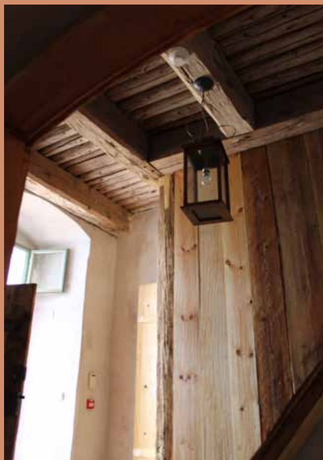
Dřevěná kolna po rekonstrukci
