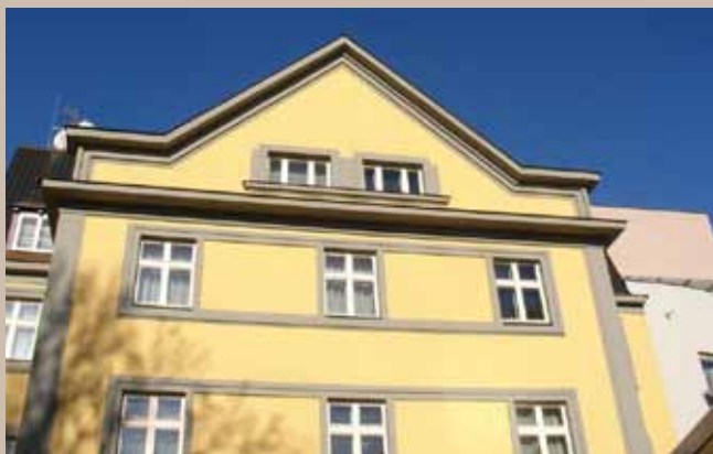
Detail zadního traktu pasáže po rekonstrukci
