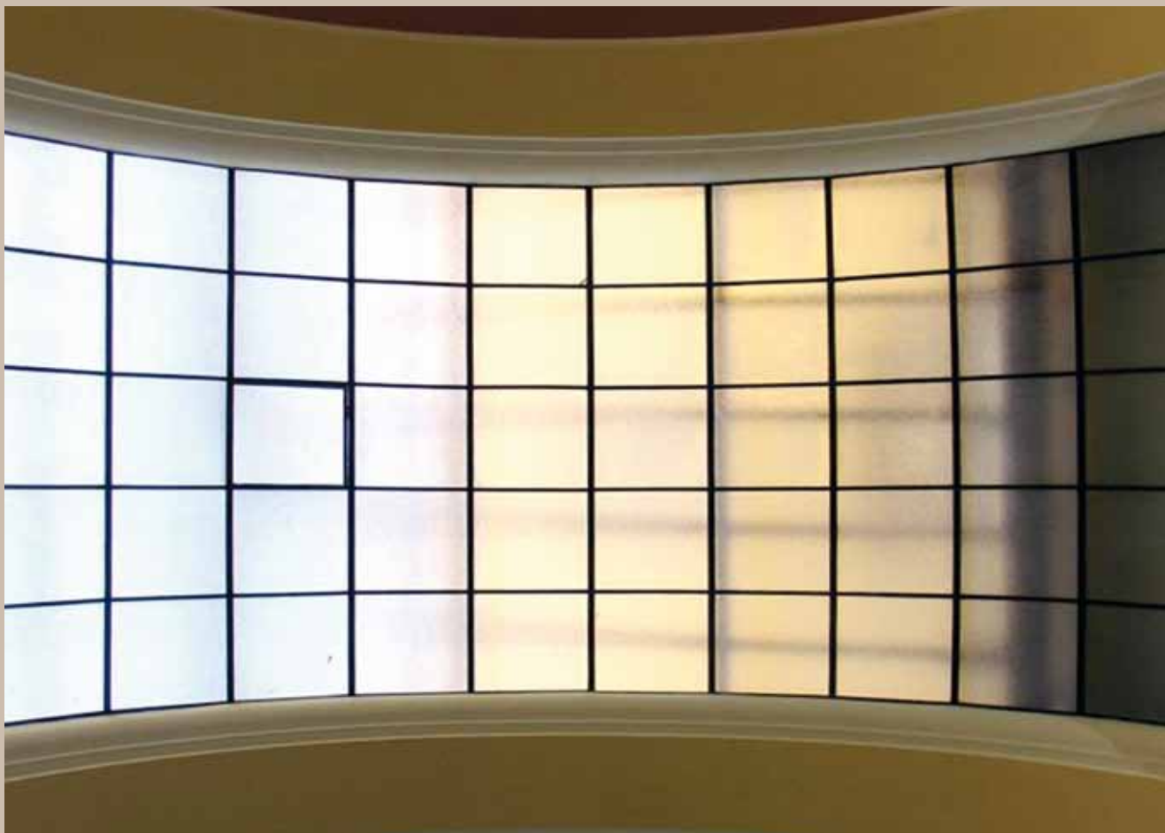
Okno pasáže s kovovou mřížkou – stav po restaurování
