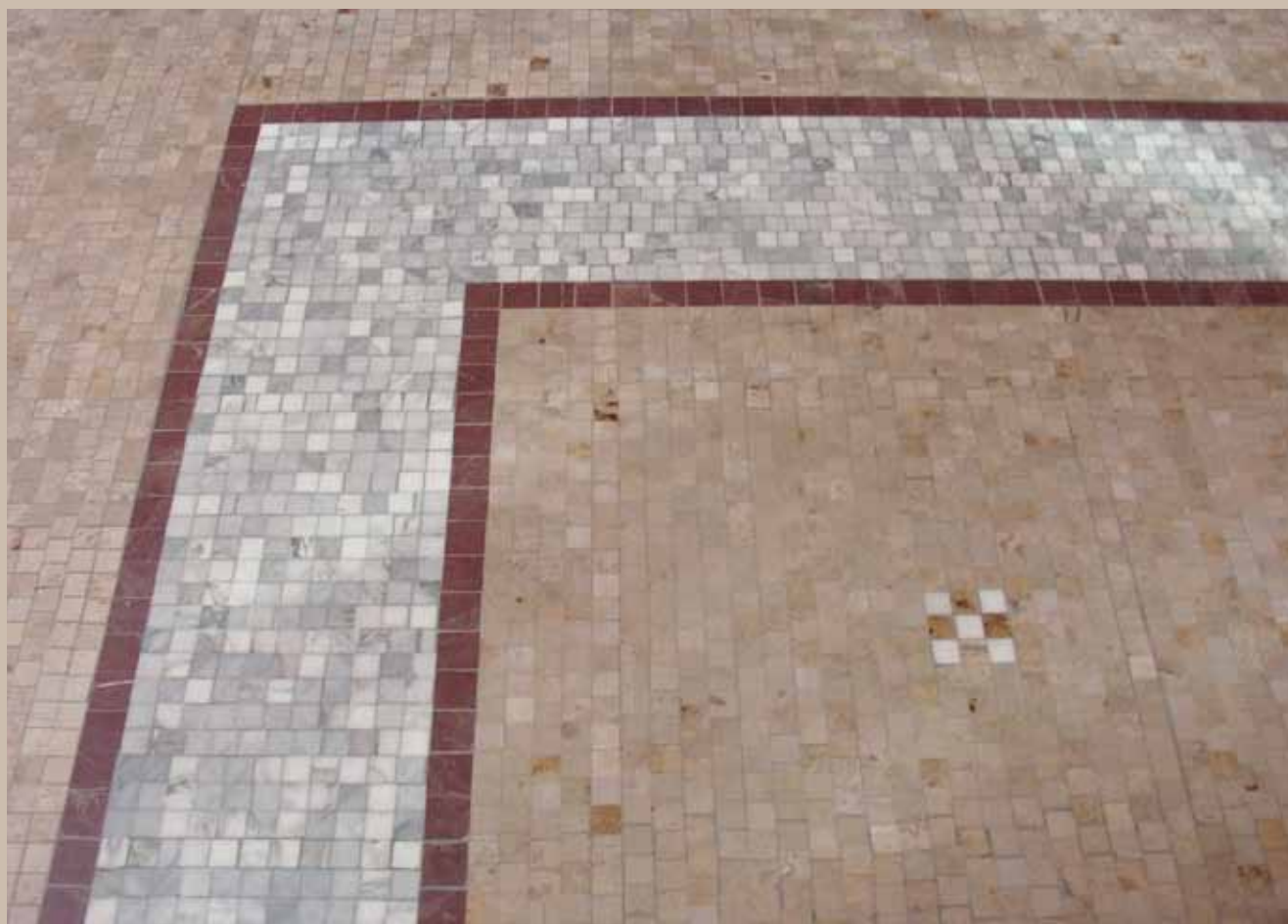
Mozaiková podlaha – stav po rekonstrukci
