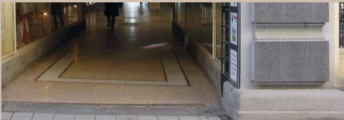
Mozaiková podlaha – stav po rekonstrukci
