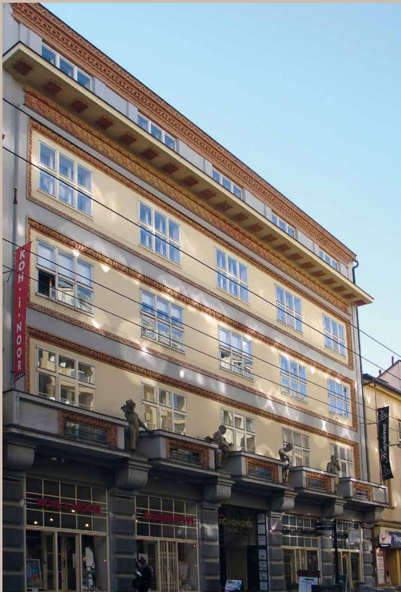
Celkový pohled na exteriér pasáže
