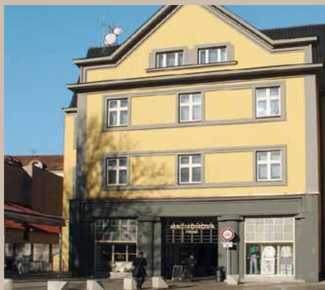
Zadní trakt po rekonstrukci
