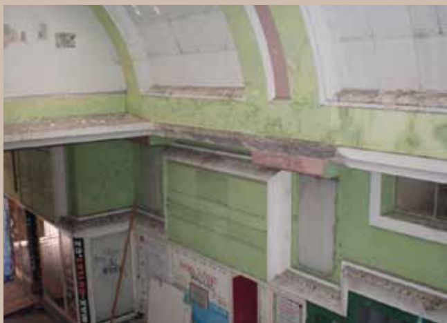
Interiér pasáže před rekonstrukcí
