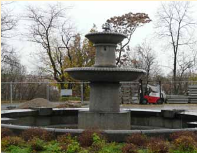
Kamenná kašna – pohled od severu – stav před rekonstrukcí
