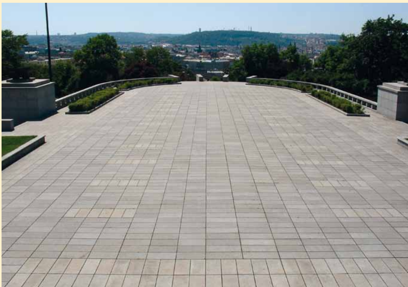
Čestný dvůr – stav po celkové rekonstrukci
