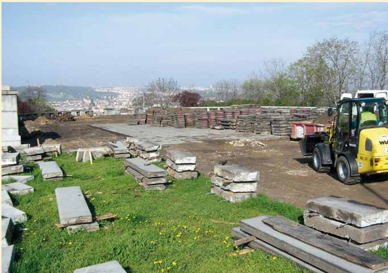
Čestný dvůr – průběh prací
