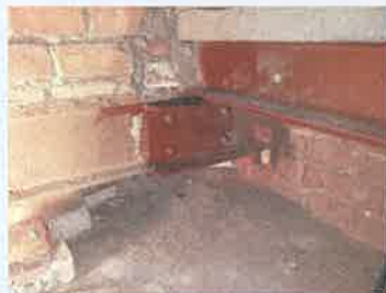
▲ Obr. 10 Nosná konstrukce uvnitř trúnů – stav po provedení sanačních opatření
