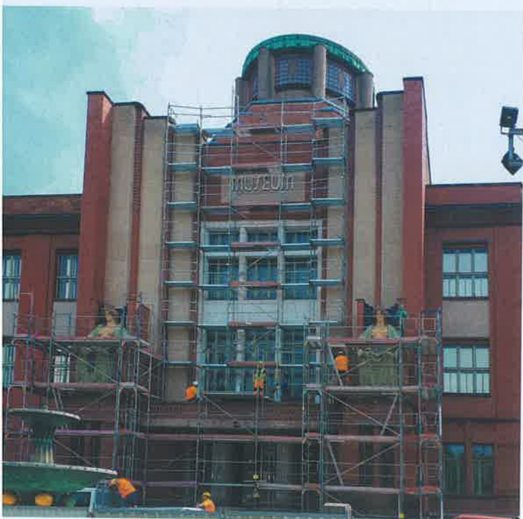
▲ Obr. 6 Budova muzea před odstraněním barevného nátěru lícových cihel
