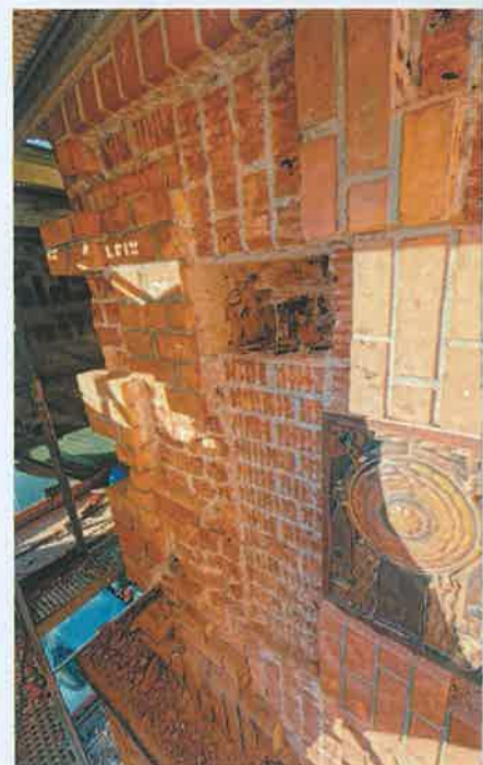
▲ Obr. 13 Postup prací při odstranění nevhodných či poškozených lícových cihel trúnů, včetně odhaleného uložení železné traverzy – vnitřní nosné konstrukce trúnů
