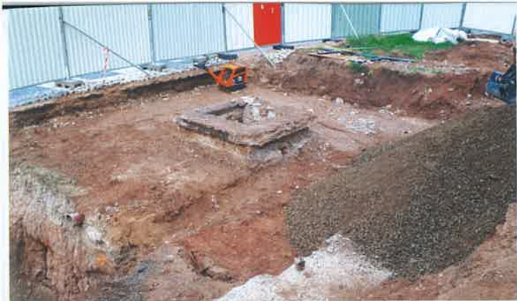
▲ Obr. 2 Úprava základů a terénu kašny
