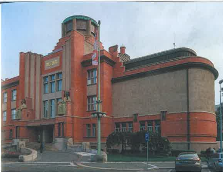
▲ Obr. 8 Budova muzea po dokončení obnovy vnějšího pláště (rok 2019)
