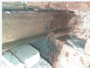
▲ Obr. 9 Pohled na nosnou konstrukci uvnitř trúnů před sanací a statickým zajištěním
