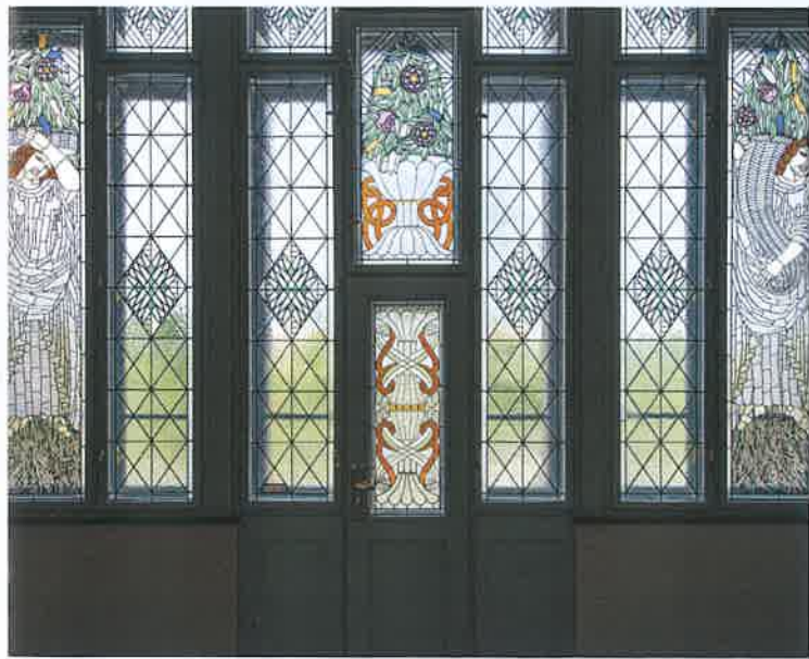
🏡 Obr. 17 Zrestaurovaná vitrážová okna
