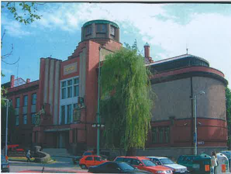
▲ Obr. 5 Budova muzea před obnovou vnějšího pláště (rok 2002)
